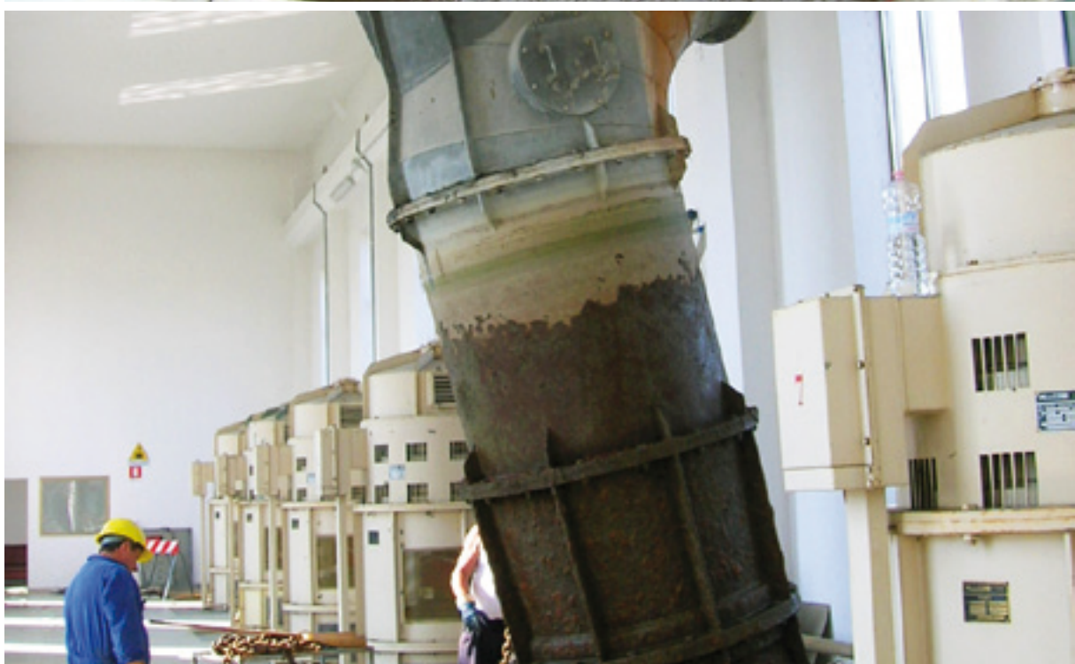
Manutenzione elettropompe – Cavanella Po (RO)
